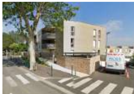
Logements sociaux à Sigean (à gauche, Patrimoine SA Languedocienne) Sources : google maps
