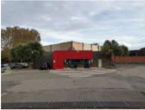
Le gymnase Pierre de Coubertin
