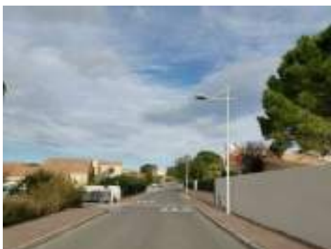
Des liaisons douces interquartiers à valoriser Source : Urban Projects YE / Google Street View
