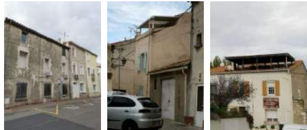
Un bâti ancien dévalorisé par des éléments parasites en façades et toitures
