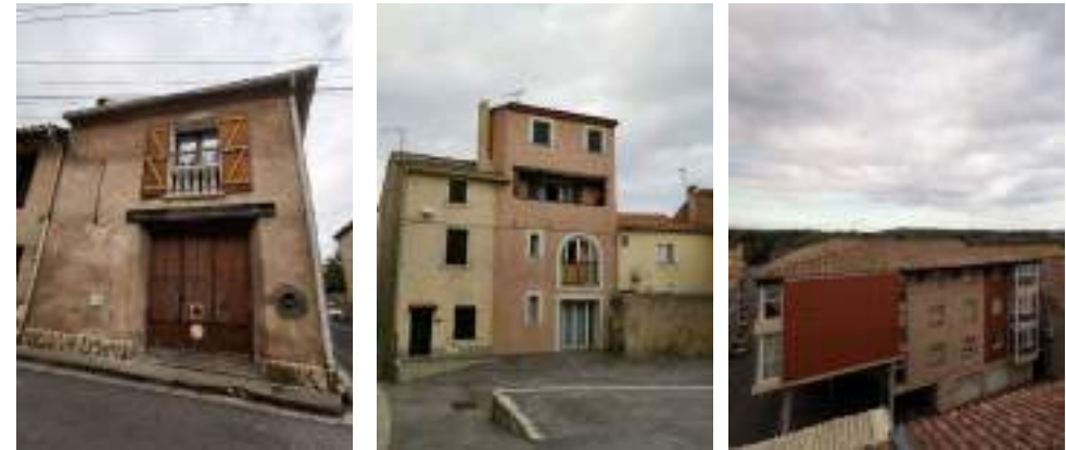
Des formes et matériaux contemporains peu intégrés au cadre bâti et peu respectueux de l'architecture traditionnelle
