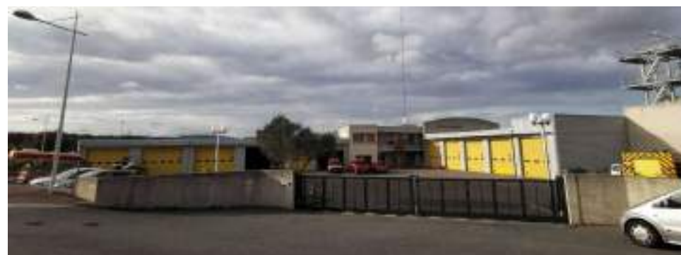
La caserne de pompiers Source : Urban Projects YE
